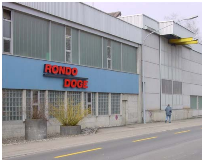
Abb.1: Betriebsgebäude der Seewer AG in Burgdorf. Ob in Zukunft vermehrt Mitarbeiter zu Fuss oder per Velo zur Arbeit gehen?
